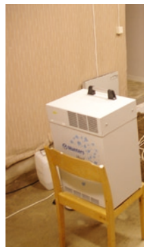
Ovan, fuktskador upptäcktes när musikstudion skulle byggas. Till höger, klipp ur Arbetarbladet 3 mars 2006.
